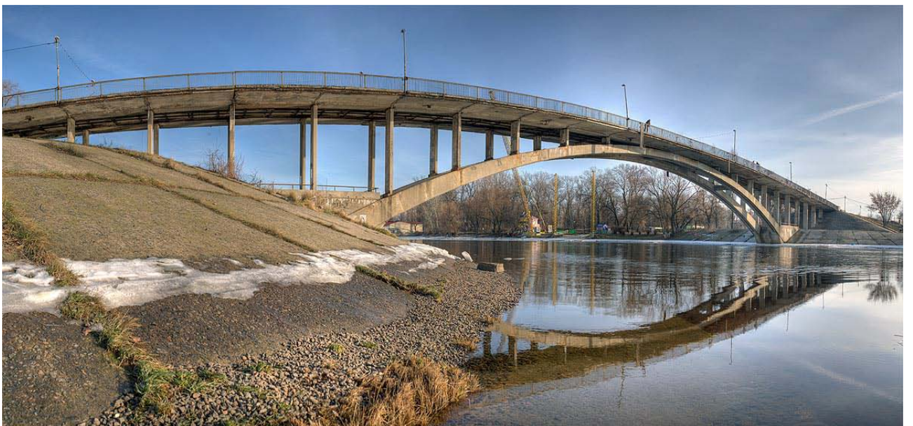
Венецианский мост длиной 144 м, соединяющий центральную часть Гидропарка с Долобецким островом, возведен в 1966 году.
