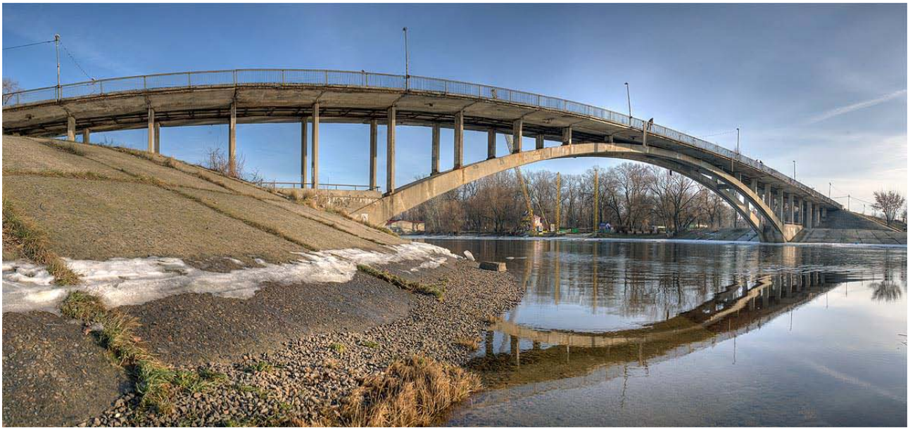
Венецианский мост длиной 144 м, соединяющий центральную часть Гидропарка с Долобцким островом, возведен в 1966 году.
