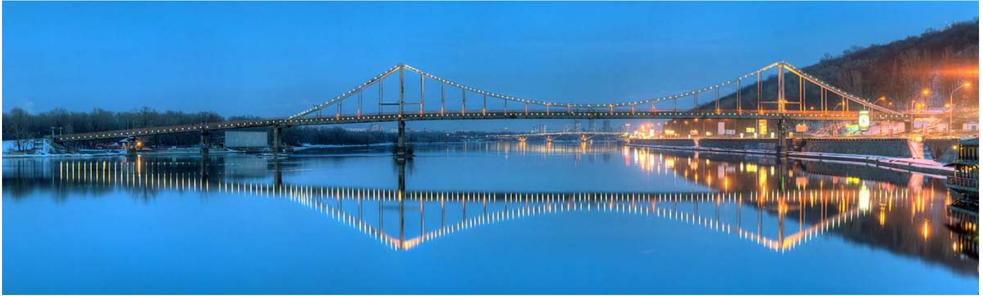
Пішохідний міст Pedestrian Bridge
